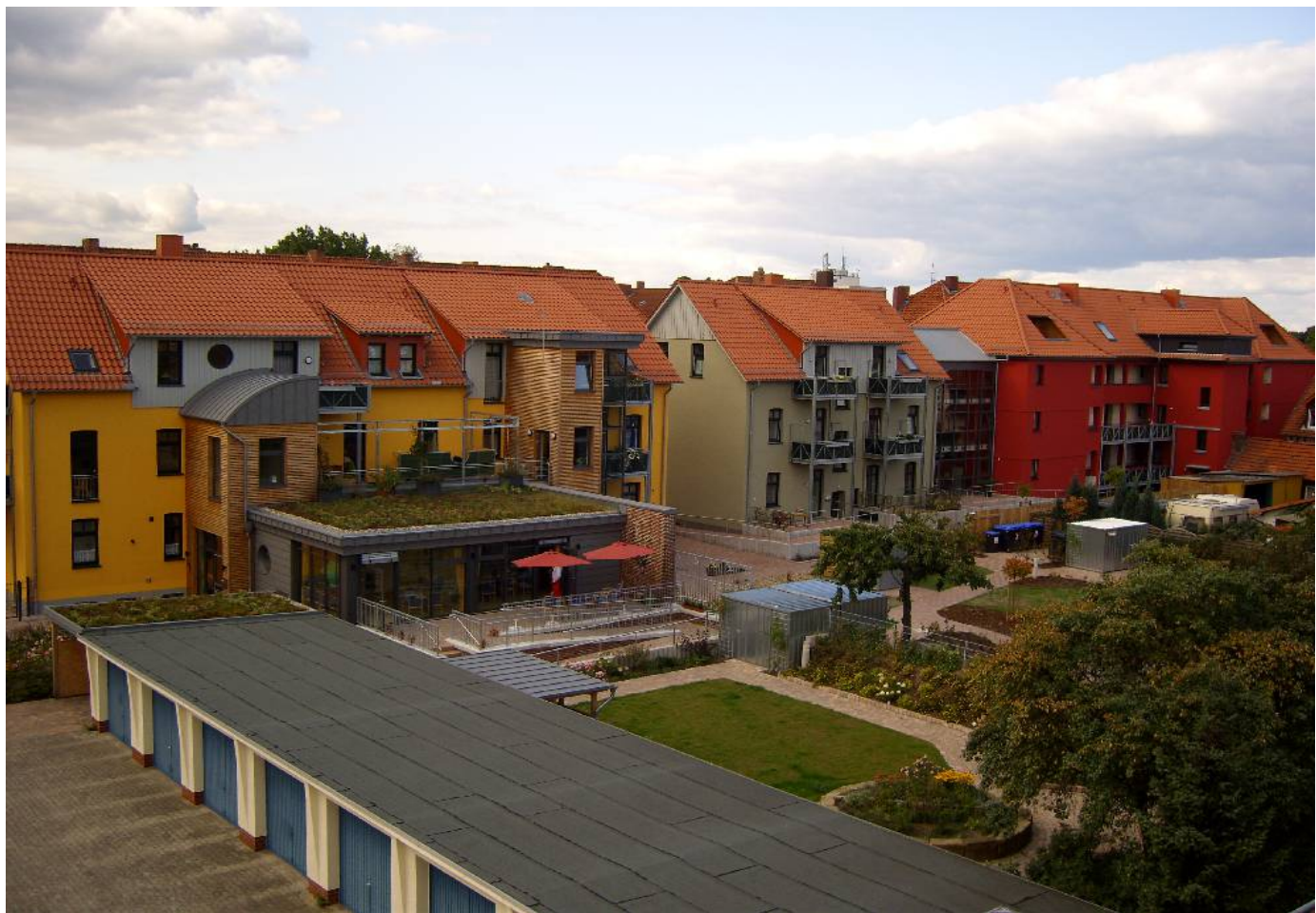
Hattendorfstraße 1 – 5 nach der Sanierung
