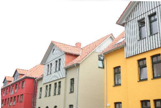
Hattendorffstraße 1 – 5 nach der Sanierung
